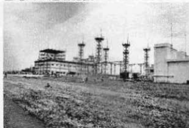
基地内の通信施設
