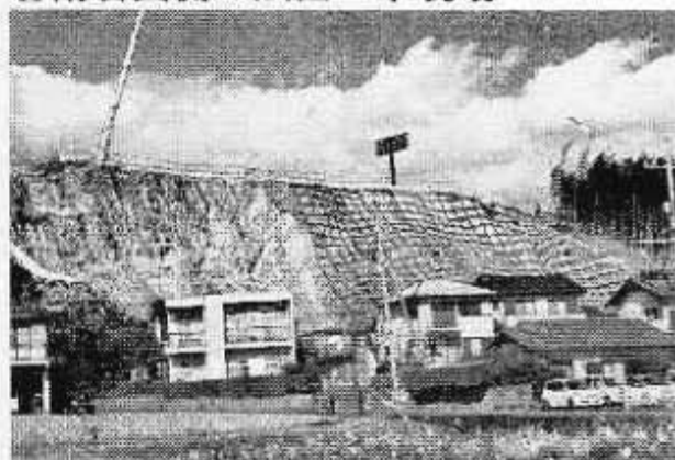
⑧南岩国側の法面工事現場
